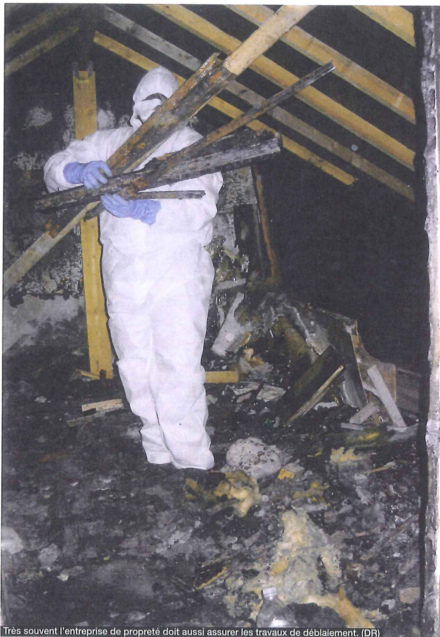
Très souvent l'entreprise de propreté doit aussi assurer les travaux de déblaiement. (DR)
